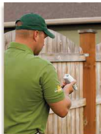
Si può stabilire la migliore posizione di installazione utilizzando l'indicatore di intensità del segnale
